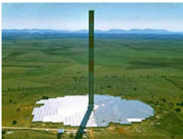
Prototyp des Aufwindkraftwerks in Spanien: "Robustes Low-Tech-Gerät"
